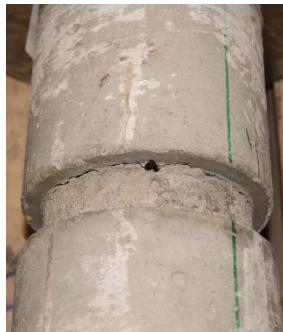
Figure 50 : Perçage des trous de  $\frac{1}{4}$ '' dans la fissure pour insertion des tubes d'injection
