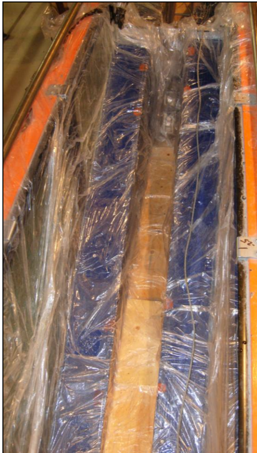
Figure A.7 : Fixation de la membrane étanche à l'amont.
