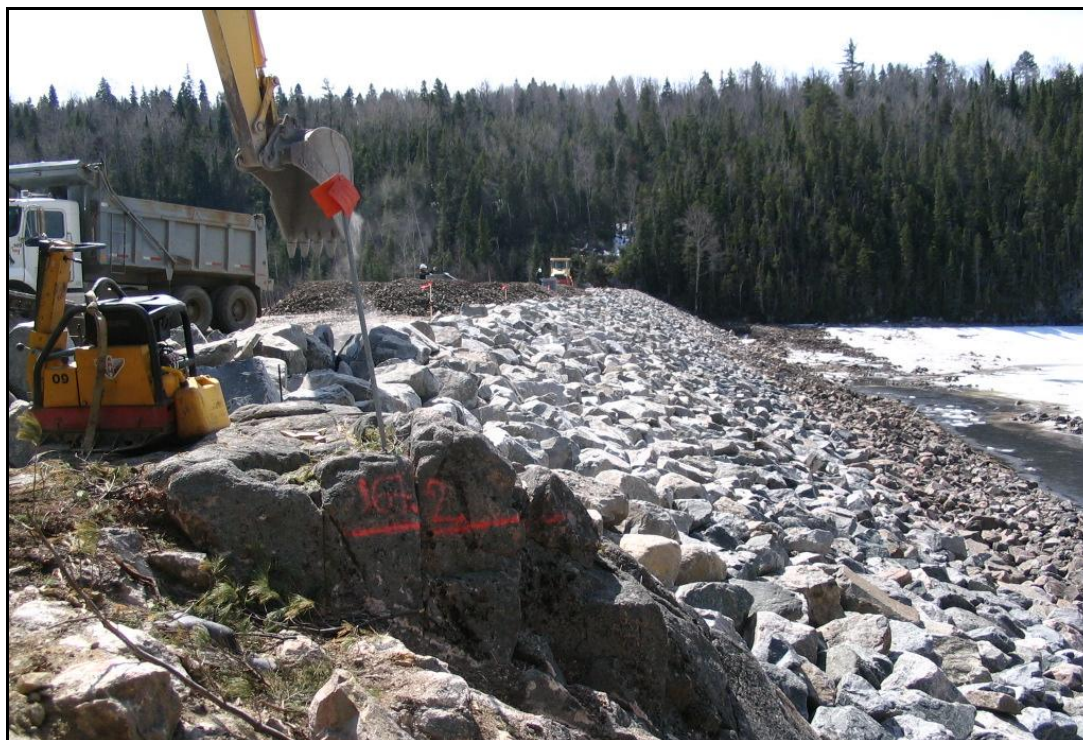
Figure 2.5 : Rehaussement de la crête de la digue Moncouche en 2009.
