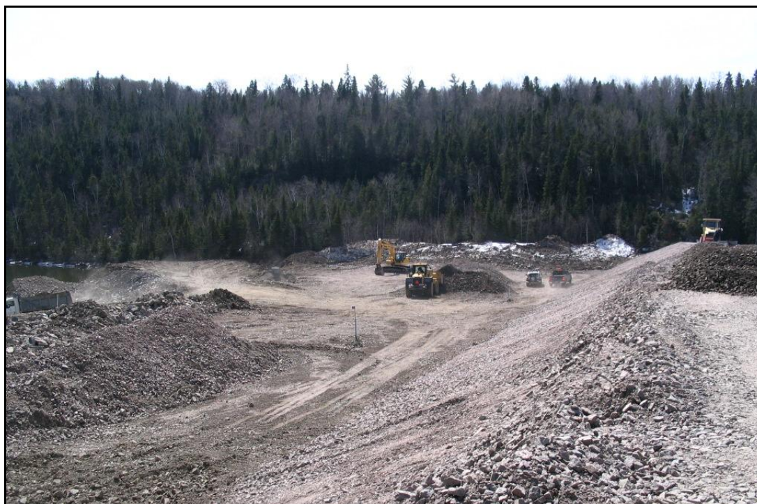
Figure 2.6 : Réfection du talus aval de la digue Moncouche en 2009.
