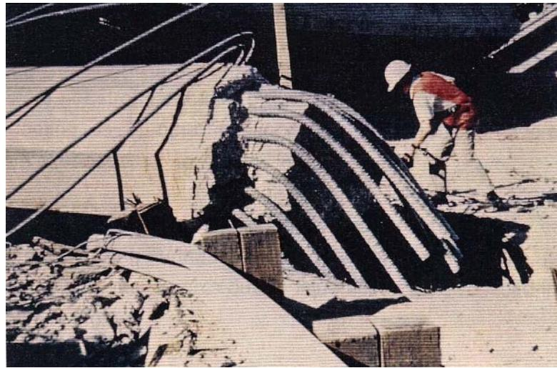
Figure 2.14 Rupture par arrachement (San Fernando 1971), (Priestley et al., 1996)
