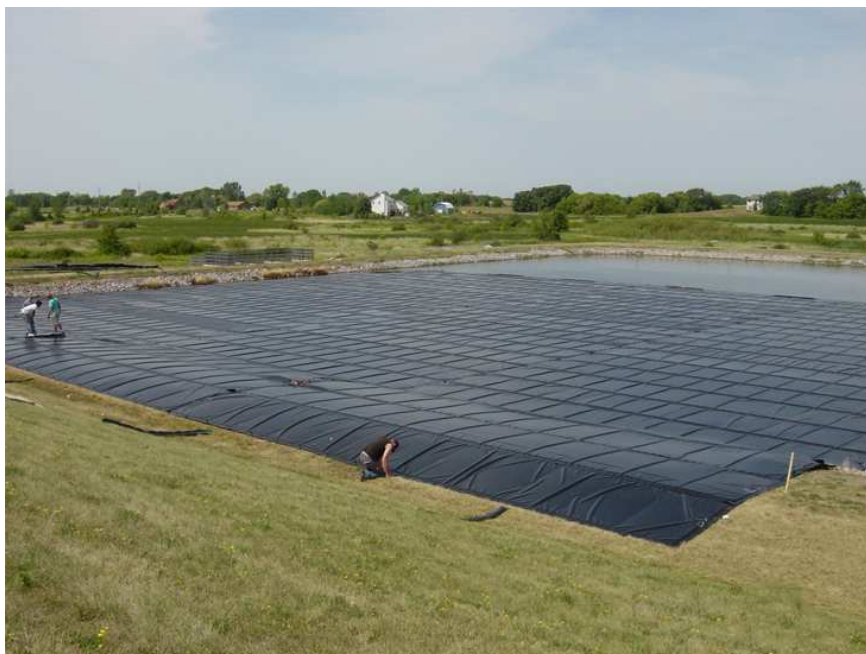
Figure 1-1: Exemple d'une géomembrane installée sur site (Solmax website)
