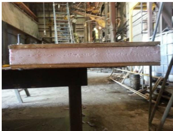
a) Avant installation
