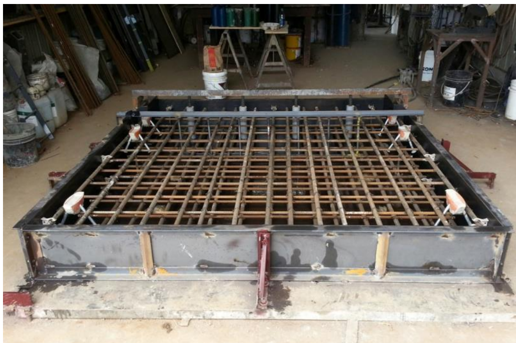
Figure 4-8: Coffrage de la dalle d'ancrage
