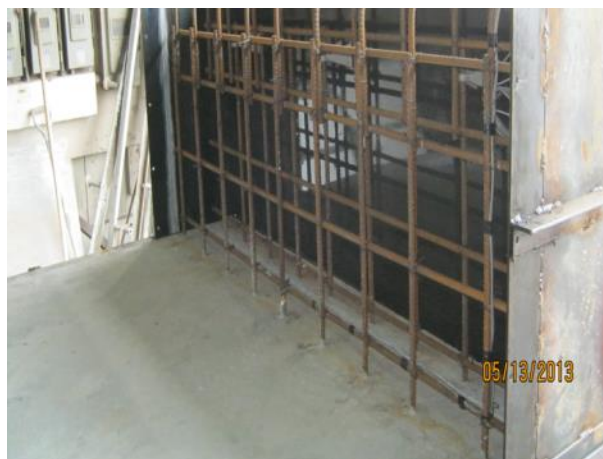
b) Avant la coulée du parapet
