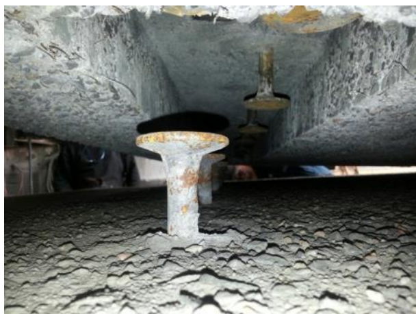
a) Alignement des ancrages
