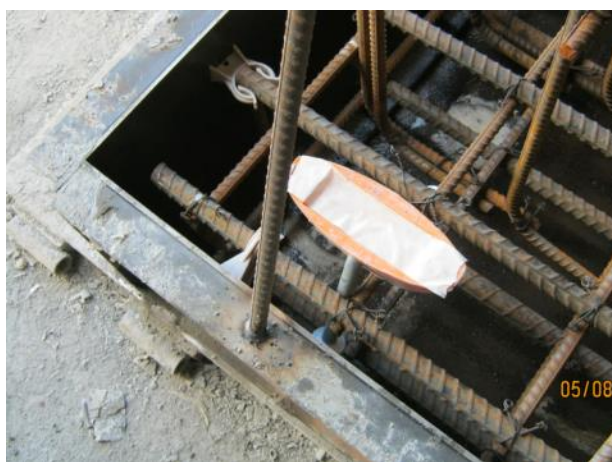
a) Avant coulée
