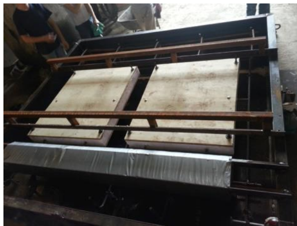
b) Après installation
