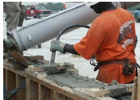
b) Vibration du béton coulé
