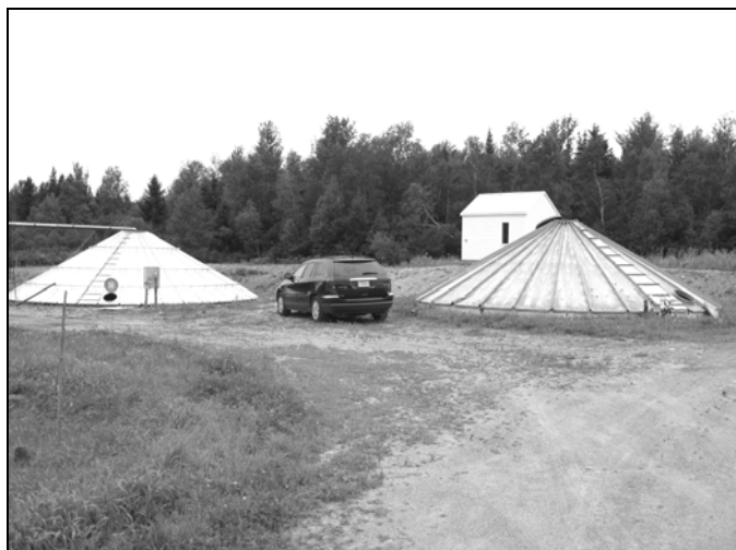
Photo 10A : Premier silo de boues brutes à gauche avec bâtiment de chaulage et dernier silo pour décanter le surnageant chaulé
