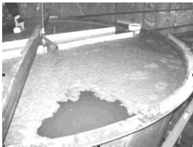
Photo 6F : Accumulation de flottant avec déflecteur
