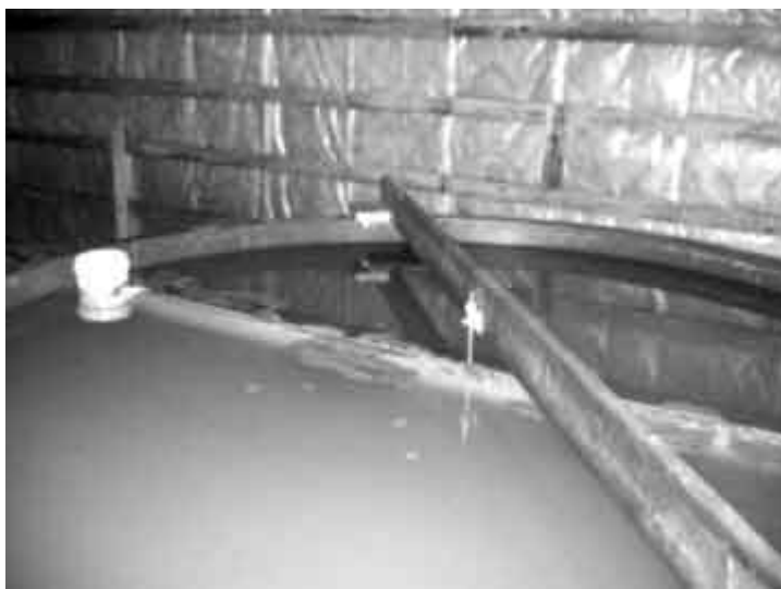
Photo 6A : Bris de support de concentrateur Photo 6B : Remontée de boues et pertes avec le surnageant éclairci
