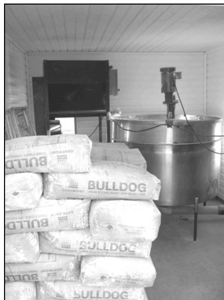
Photo 10B : Bâtiment de chaulage doseur à sec de chaux et contenant du mélangeur rapide
