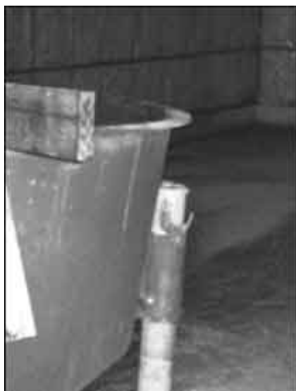
Photo 6A : Bris de support de concentrateur Photo 6B : Remontée de boues et pertes avec le surnageant éclairci
