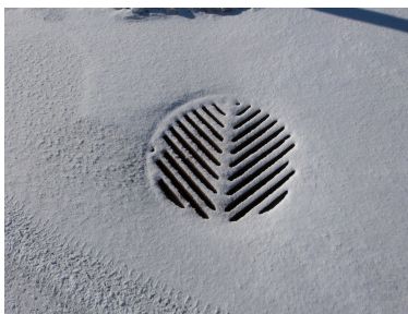
Figure 3.3 Photo du puisard PU-02, diamètre de 900 mm.
