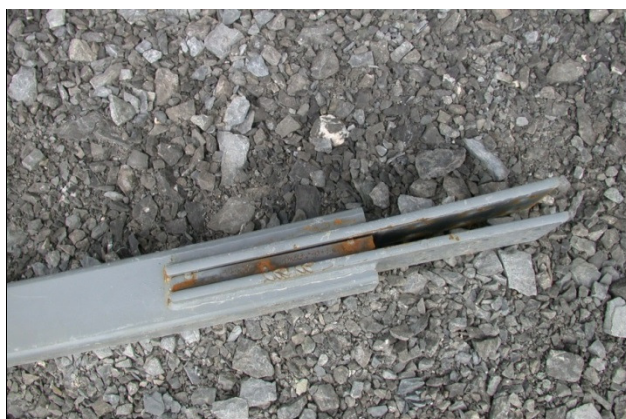
Figure 3-29: Cales placées entre les plaques de transfert d'assemblages en cisaillement double de diagonales HSS (Source : R.Tremblay).
