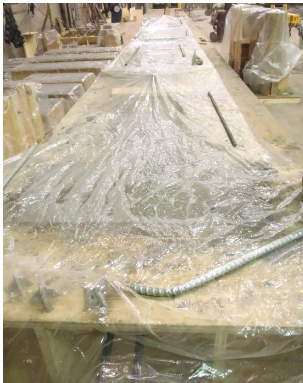
Figure 4-16 : Poutre recouverte de polythène
