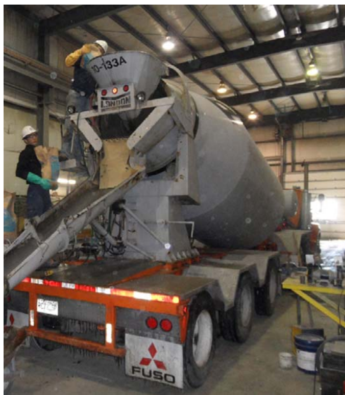
Figure 4-15 : Insertion des fibres dans le camion-toupie
