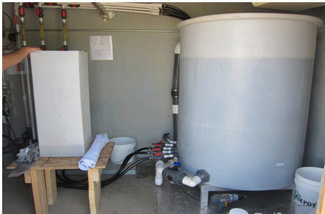
Figure 2–6: Réservoir temporaire d'injection (gauche) et réservoir d'alimentation du cabanon 2 (droite)
