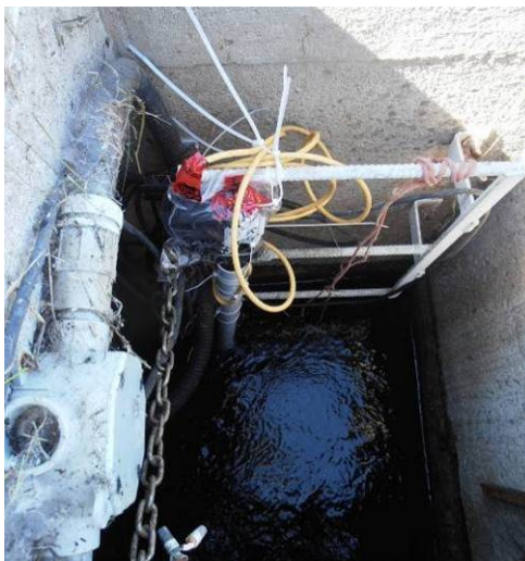
Figure 3.11 : Installation de la sonde de mesure du pH dans le regard d'effluent de la station de Sainte-Julie
