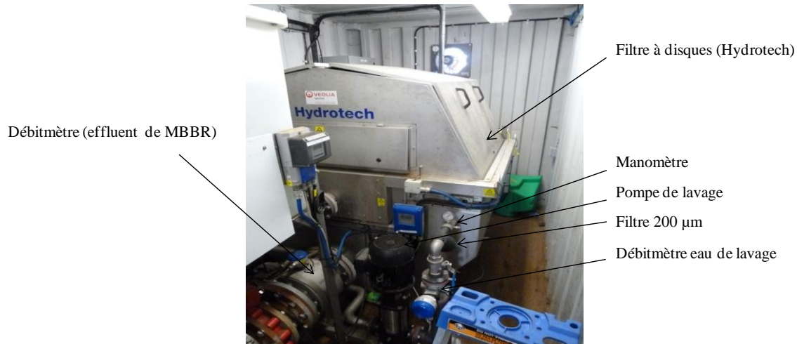
Équipement entourant le filtre à disques (Hydrotech)
