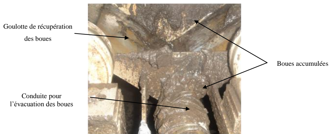
Figure 4-40 : Photo de l'accumulation de boue à l'extérieur des disques
