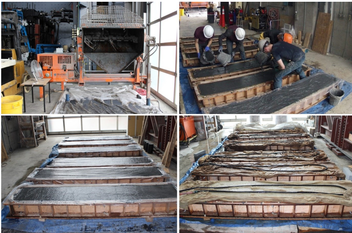
Figure 4-3 Production de la section en BFUP des dalles
