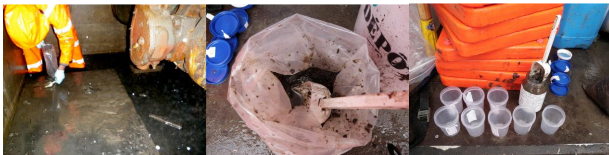
Figure 2.3 Échantillonnage des sédiments d'une chambre d'aqueduc
