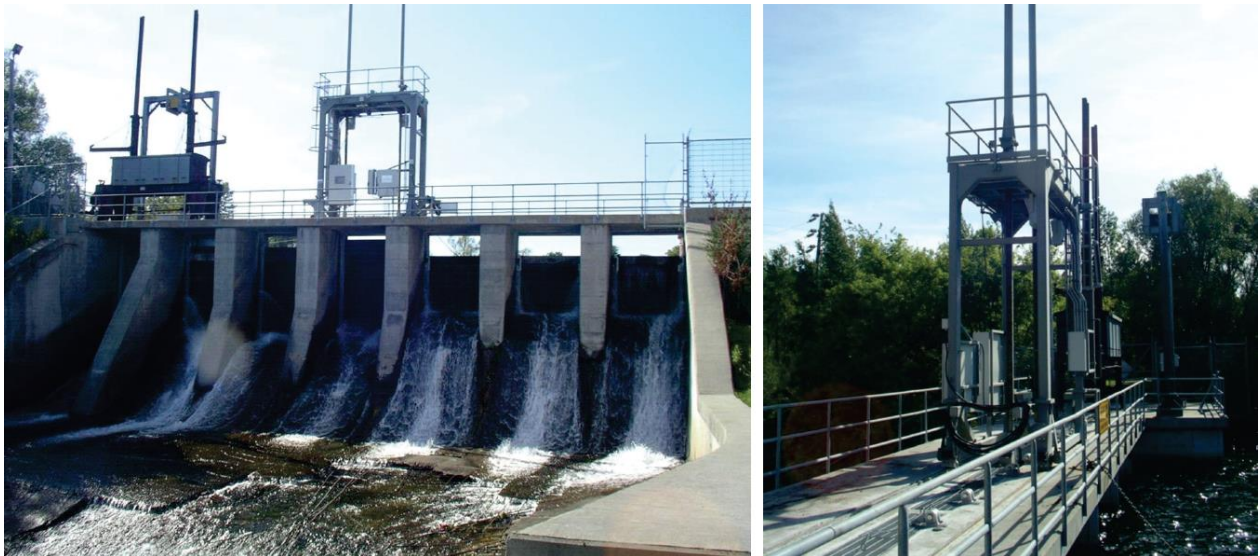
Figure 2.9 Installation d'une grue mobile par Mecan Hydro sur le barrage du Magog au Québec, entre 2008 et 2009 pour un barrage d'Hydro-Sherbrooke.
