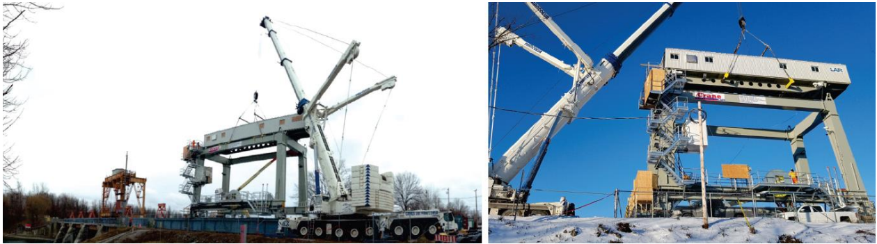
Figure 2.8 Installation de deux grues portiques de capacité 136T par le groupe LAR Crane sur le barrage du Salaberry-de-Valleyfield au Québec entre 2015 et 2017 pour un barrage d'Hydro-Québec.
