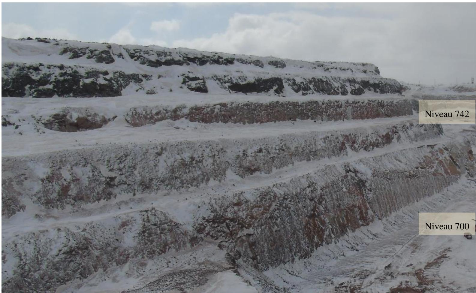
Figure 6.10 Implémentation du design entre les niveaux 742 et 700 (Secteur Nord-Est)
