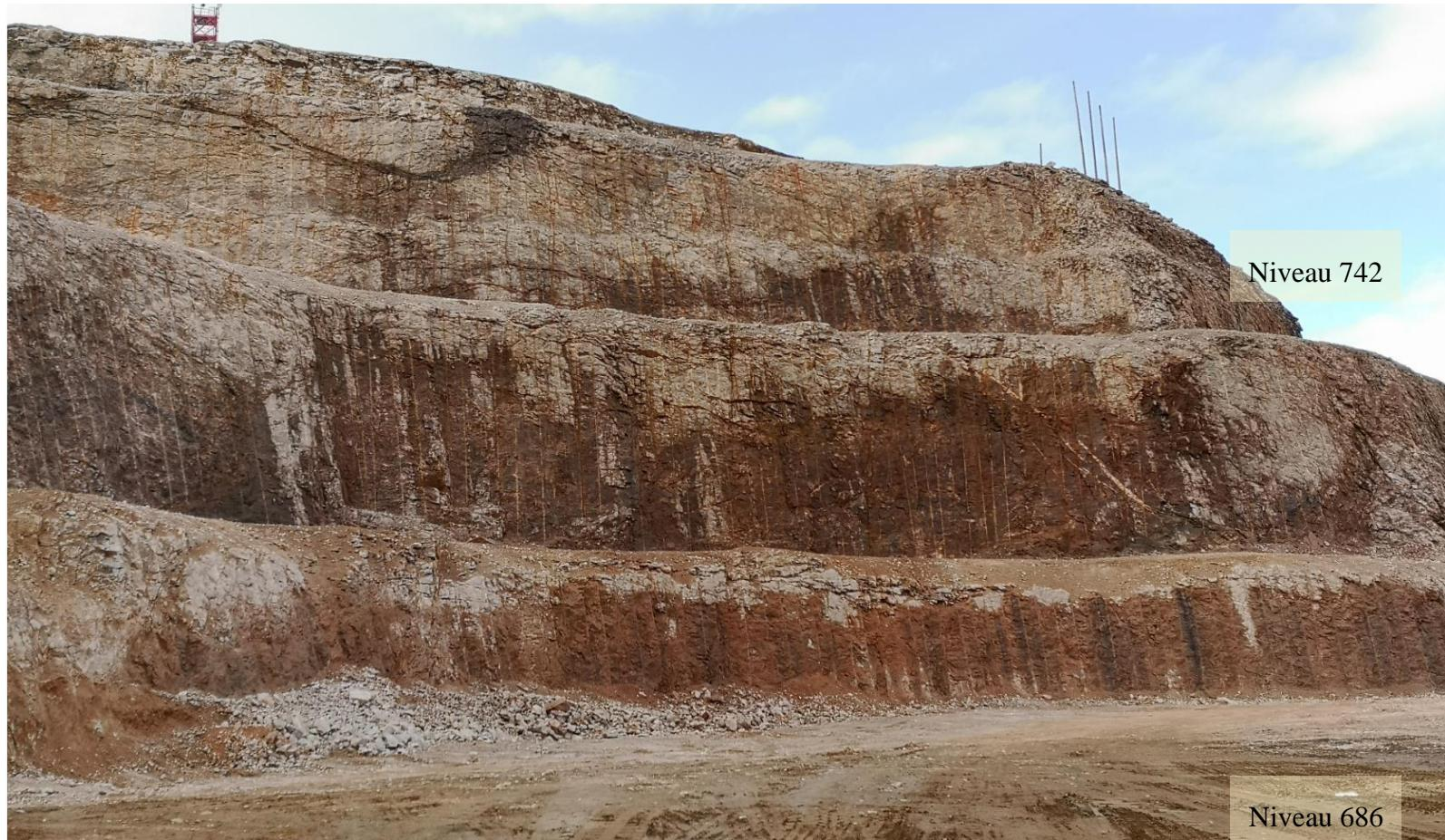
Figure 6.7 Implémentation du design entre les niveaux 742 et 686 (Secteur Sud-Ouest)
