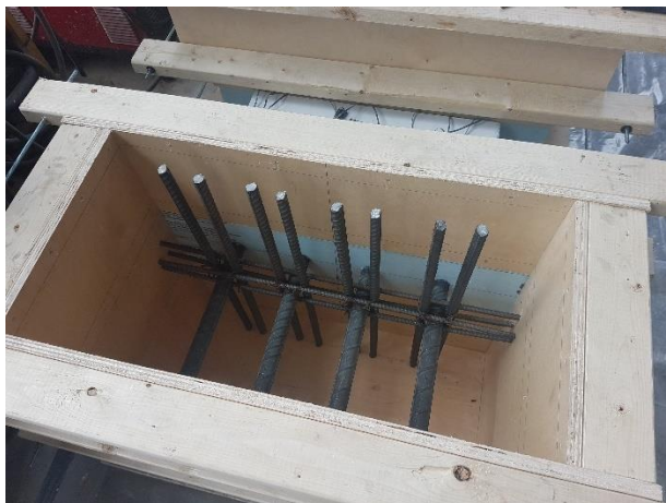
Figure 5.13 Armature supplémentaire mise en place
