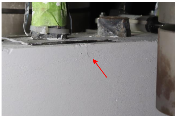
a) Barre 1, face coffrée
