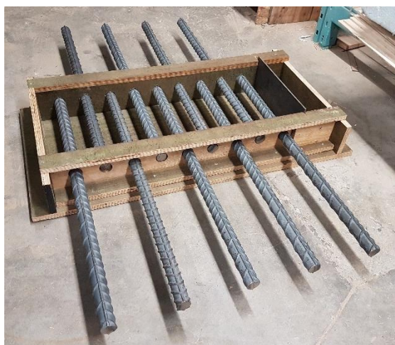
Figure 5.5 Coffrage du spécimen NCS avec barres d'armature en place
