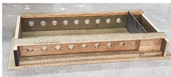
b) Coffrage réel
