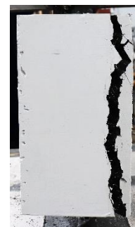
d) Extrémité coffrage
