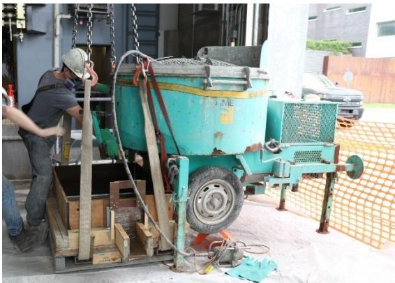
a) Remplissage du bac en bois
