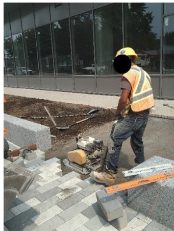
Figure 4.3.3 Aplatir le sol avec une machine.
