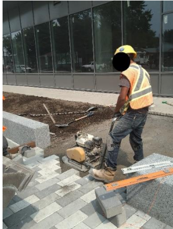
Figure 4.3.3 Aplatir le sol avec une machine.
